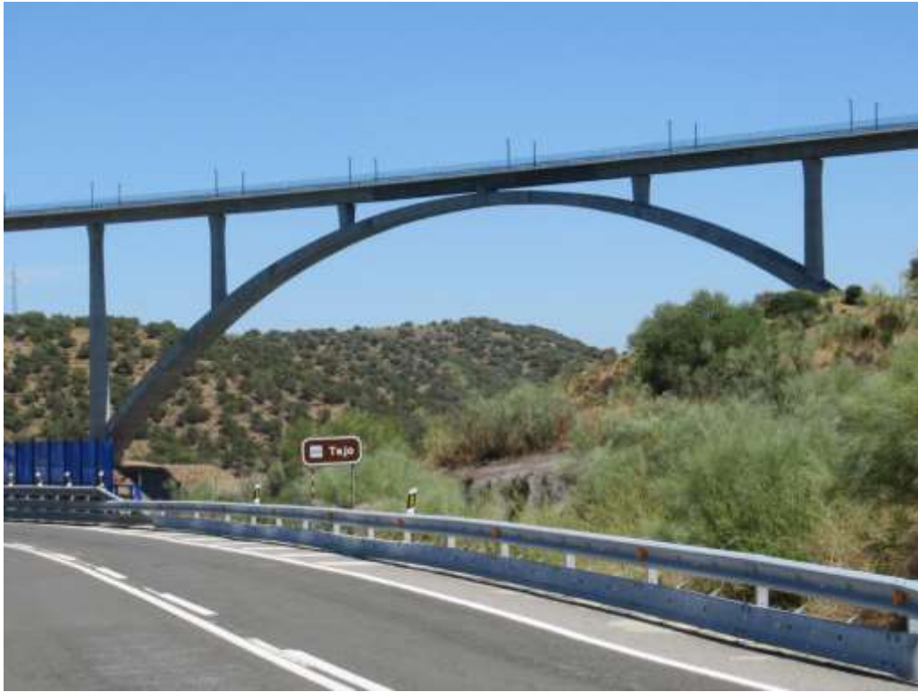
Se está electrificando el viaducto sobre el río Tajo
