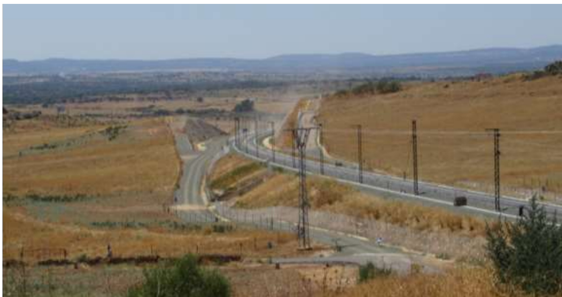
Obras del nuevo acceso a Cáceres desde el sur. Es de una sola vía, electrificada. (agosto de 2020)
