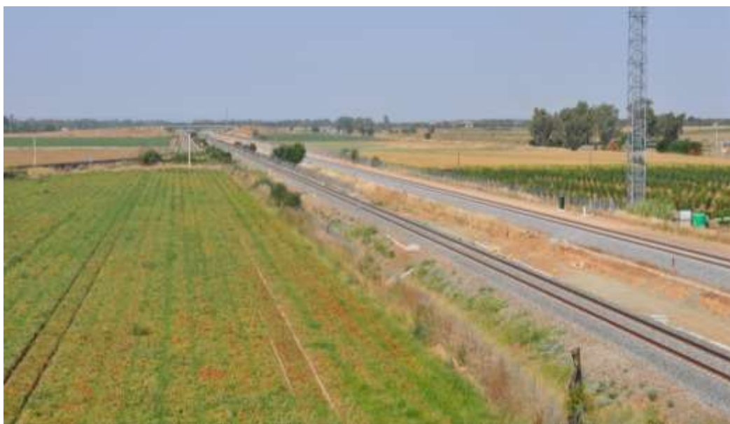
Vía convencional (a la izquierda y nueva vía, cerca de Novelda del Guadiana
